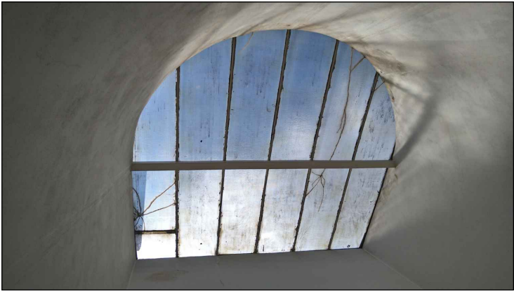
Foto stávajícího střešního světlíku z prostoru schodiště - DRÁTOSKLO
